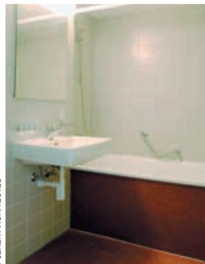
Nouvelle salle de bains, un châssis sanitaire préfabriqué intègre la technique et dissimule le meuble pharmacie.
